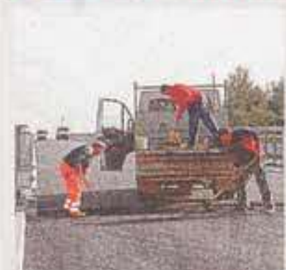
La posa dell'asfalto speciale
